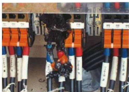
端子台の焼損
