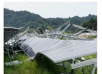
パネル飛散の例-2
