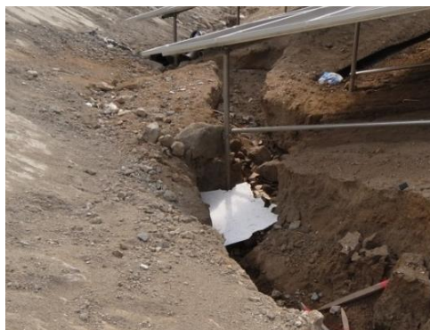
地割れの事例
