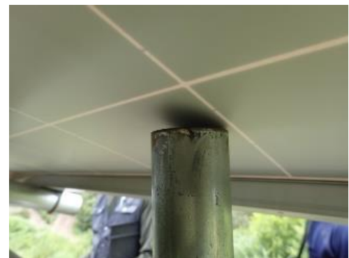
架台とモジュールの接近しすぎ
